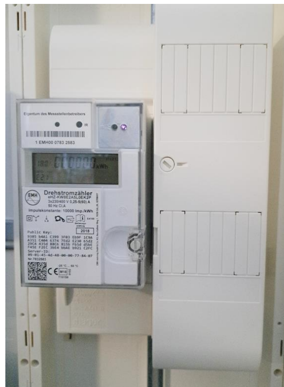
Variante 2: Zählerplatz mit einer Befestigungs- und Kontaktiereinrichtung (BKE)
